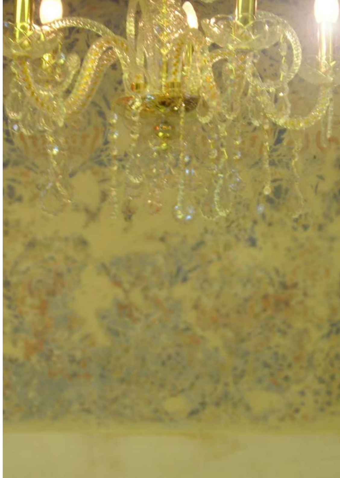
IL PARTICOLARE ■ la parete con decoro ritrovato durante la ristrutturazione
